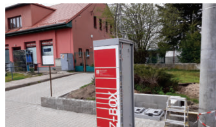
Oprava zídky a instalace Z-boxu ve Skalici (5/2021), celkové náklady 14 tis. Kč.
