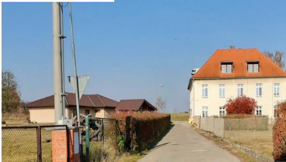
K realizaci je připraven projekt rekonstrukce zpevněných ploch u objektu MŠ v Čibuzi (předpoklad realizace 3-6/2023), předpokládané náklady 3 mil. Kč (čekáme na případné uvolnění dotačních prostředků).
