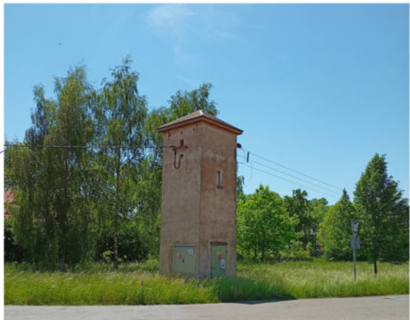
stávající trafostanice do 52 kV
