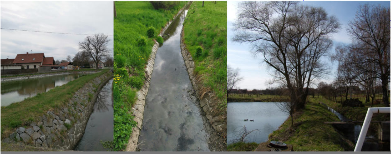
Černilovský potok protéká obcemi Skalice a Skalička, který napájí místní vodní nádrže
